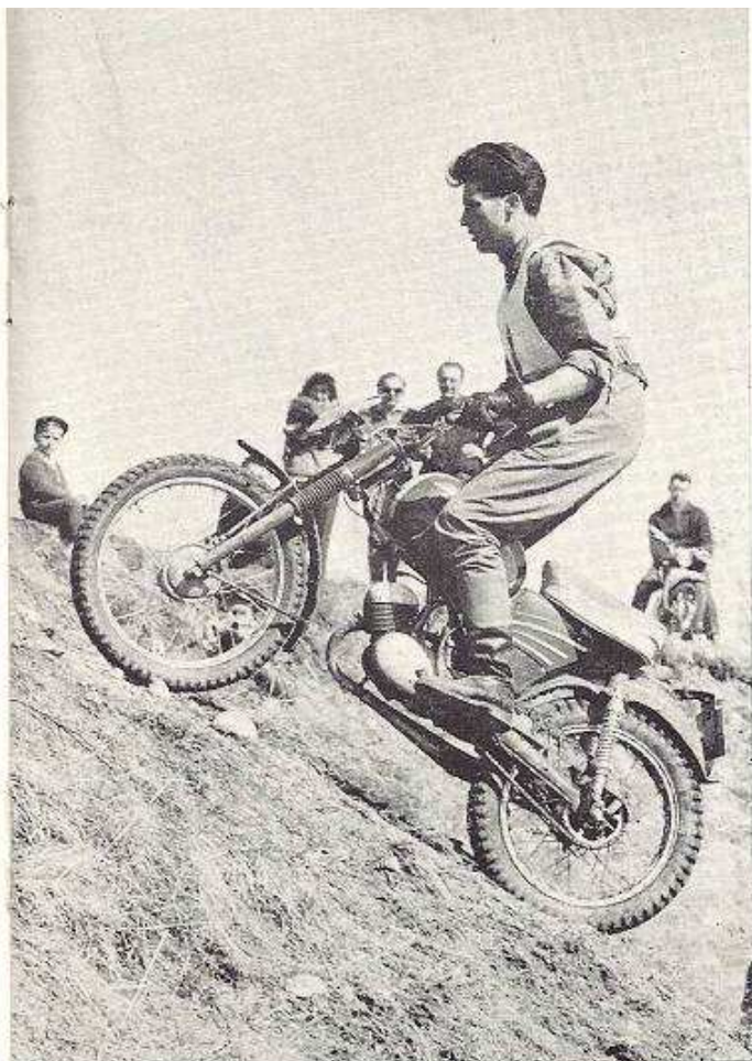
Volker Kramer auf der ZÜNDAPP GS 75 (Geländeversion) bei einer Steilauffahrt am Hang. Man sieht deutlich die klassische Haltung des Fahrers bei Steilauffahrten: Körpergewicht möglichst weit nach vorn, um ein Aufsteigen des Vorderrades zu verhindern (trotz dieser Gewichtsverlagerung beginnt im gezeigten Fall das Rad bereits abzuheben!).
